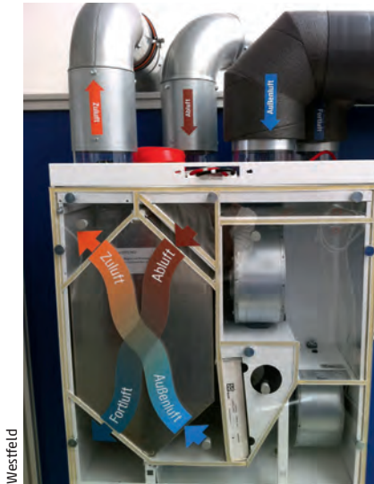
Kontrollierte Wohnraumlüftung: Gerät mit erläuterten Funktionsprinzip.
